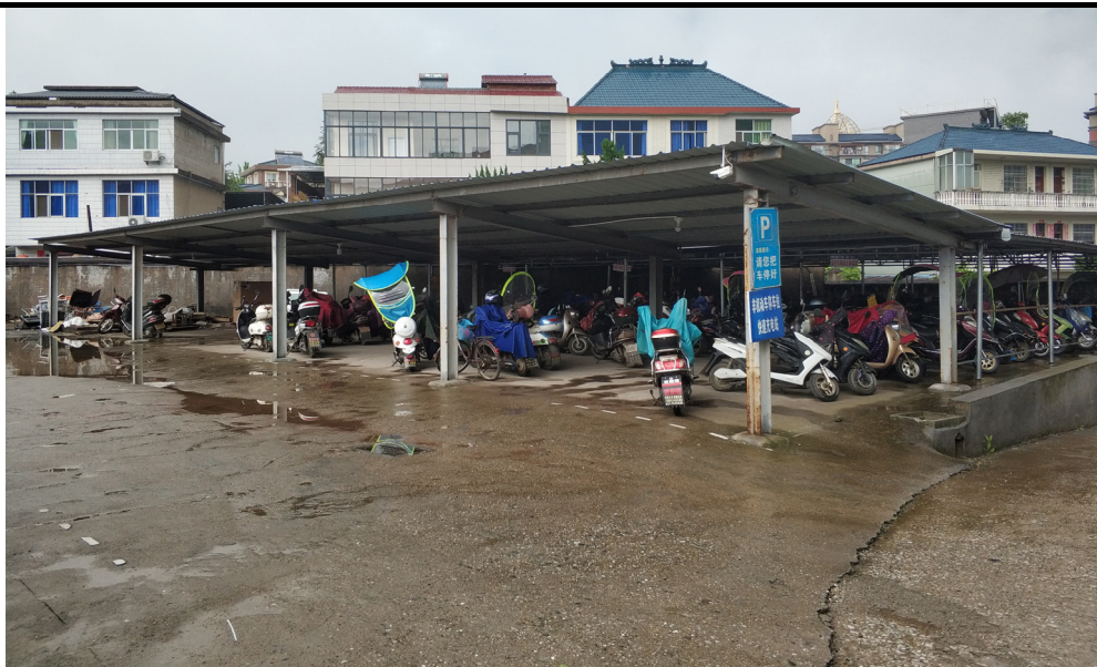
拟建放疗楼现状图
