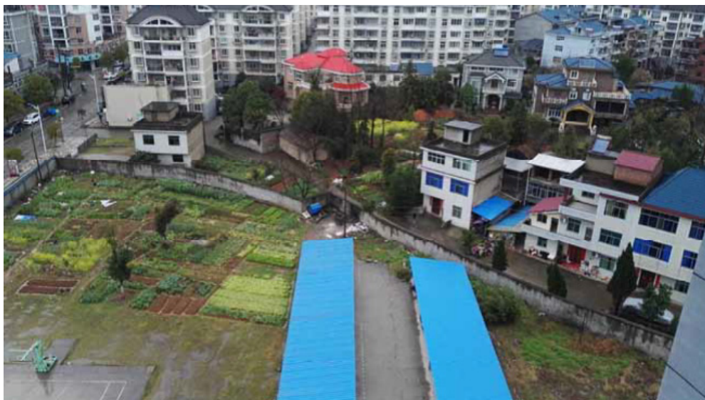
北侧日安小区
